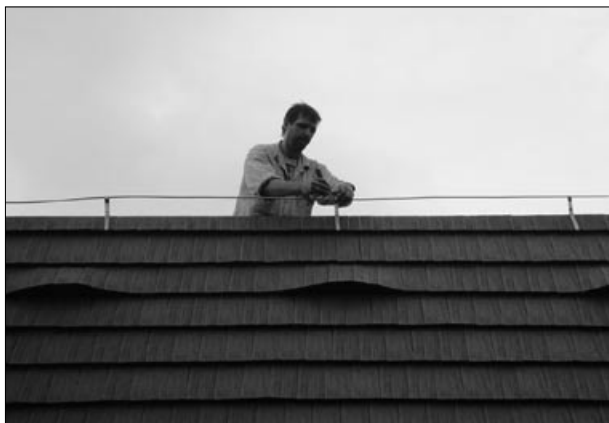
Instalace bleskosvodu – P. Prokop Diviš by měl radost
